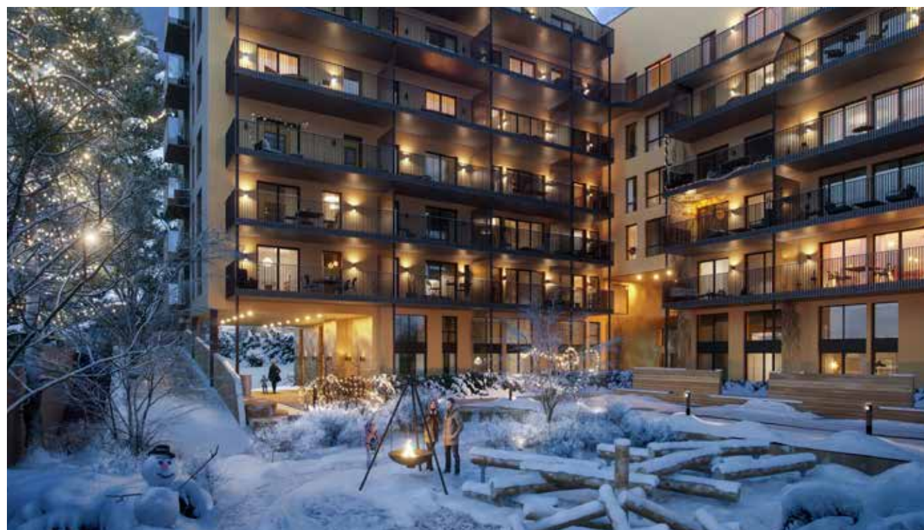
Brøter Terrasse, Lillestrøm
